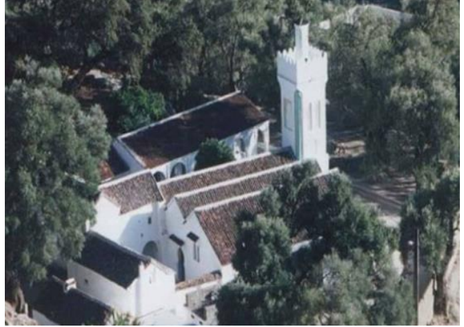
صورة المسجد قبل الترميم
