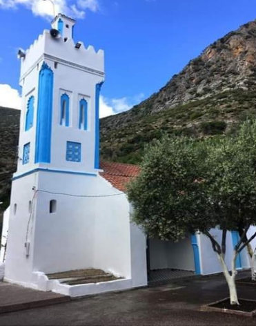
صورة المسجد بعد الترميم
